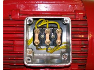
Hình 13.4 Động cơ được nối theo hình tam giác
