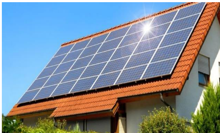
Hình 1.27: Máy nước nóng và Pin sử dụng năng lượng mặt trời
