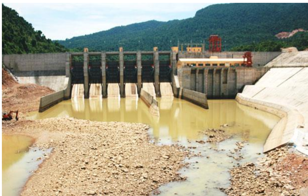
Hình 1.33: Ảnh hưởng của Nhà máy thủy điện
