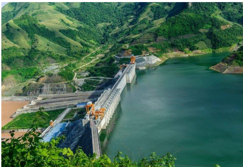
Hình 1.32: Nhà máy thủy điện
