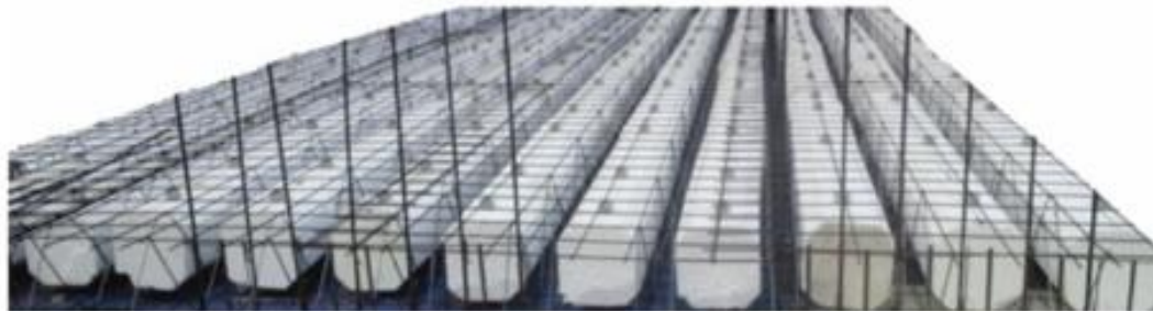
Hình ảnh 3D-VRO trước khi đổ bê tông
