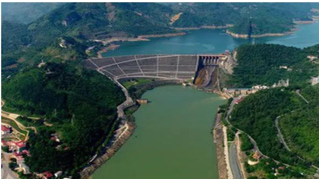
Hình 2.2 Nhà máy thủy điện
