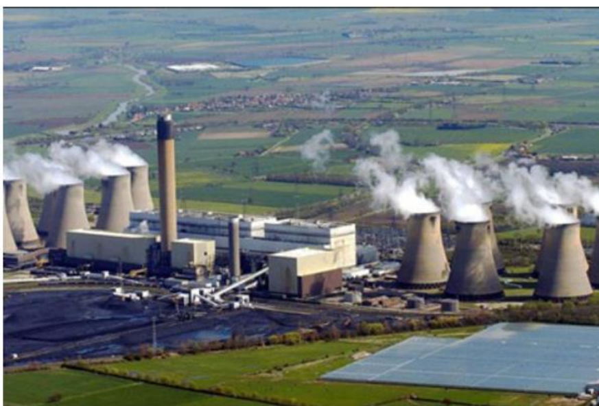
Hình 2.3 Nhà máy nhiệt điện
