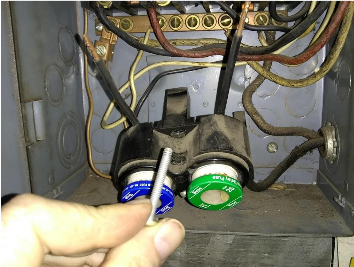
Cầu chì dạng nút dùng trong máy cắt kim loại
