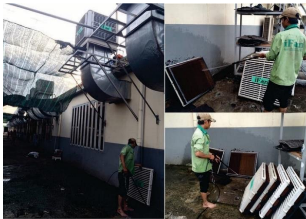
Hình 4.7. Bảo trì tấm làm mát
