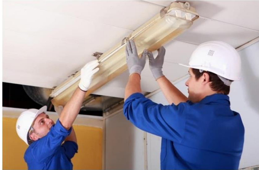
Hình 4.4. Bảo trì hệ thống chiếu sáng
