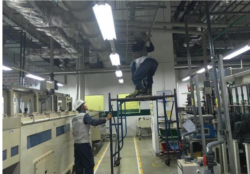
Hình 4.5. Bảo trì hệ thống chiếu sáng
