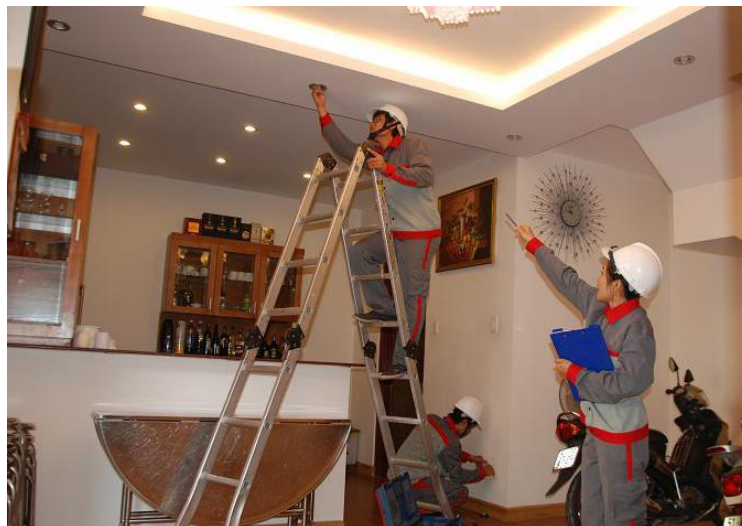
Hình 4.6. Bảo trì hệ thống chiếu sáng
