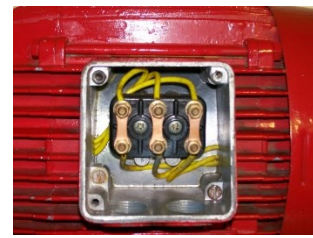
Hình 3.22 Động cơ được nối theo hình tam giác
