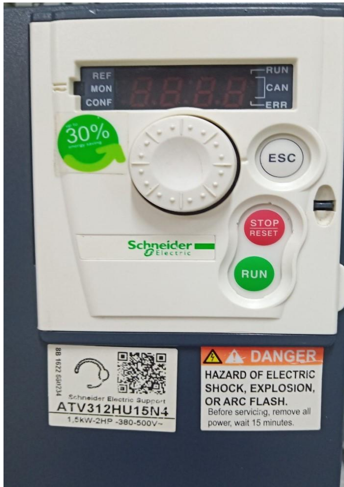
Hình 2: Biến tần điều chỉnh tần số nguồn điện
