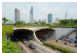
Hầm Thủ Thiêm (Thu Thiem Underground Road Tunnel) – Quận 2
